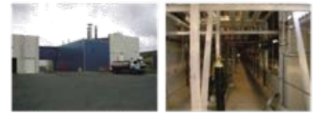
LOCALES TÉCNICOS Y RACK TÉCNICO
