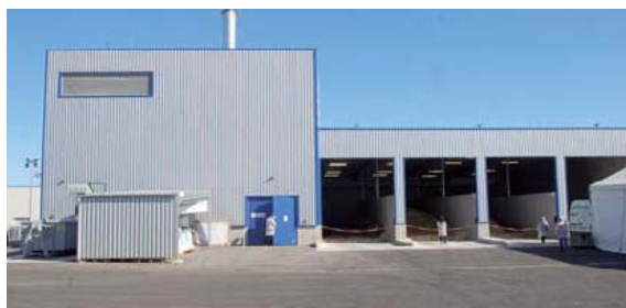
Quatre silos (720 m 3 ) assurent à la chaudière quatre jours d'autonomie.
